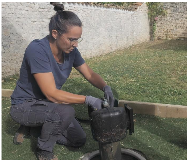
Contrôle de bon fonctionnement d'un assainissement individuel
