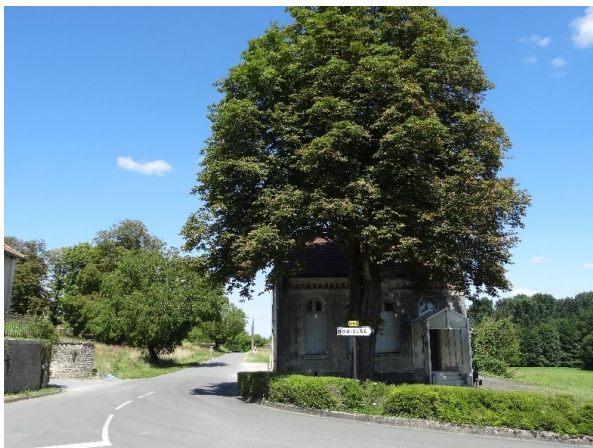
Arbre isolé, repère devant un ancien bâtiment public (Anville)
