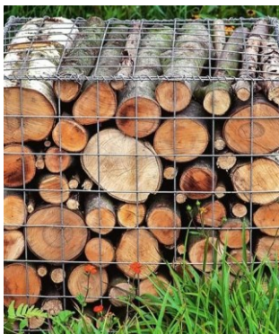
Gabion remplissage bois favorisant l'accueil de l'entomofaune
