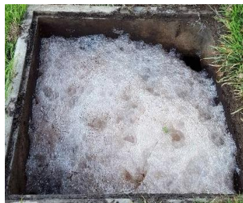
Dysfonctionnement - Présence importante de mousse
