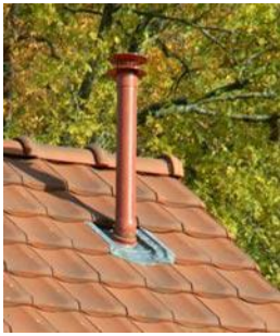
Ventilation secondaire Extracteur statique
